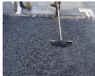
本復旧工 アスファルト舗装を新しく舗装する
