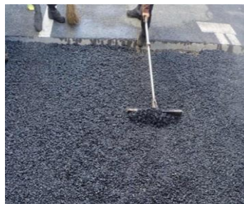
本復旧工 アスファルト舗装、街きょブロック等を新しく舗設する
