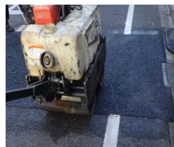
本復旧工 アスファルト舗装、街きょブロック等を新しく舗設する
