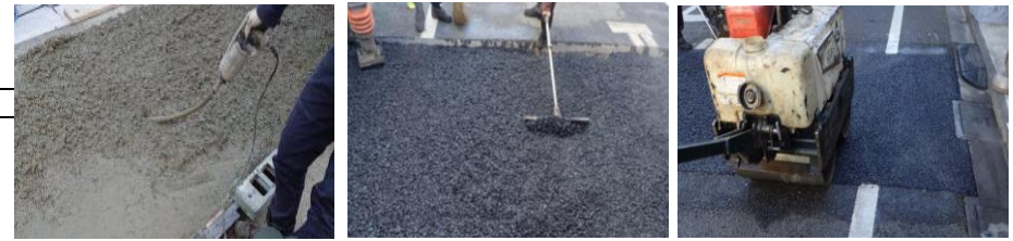
アスファルト舗装・セメントコンクリート舗装を新しく舗設する工事
