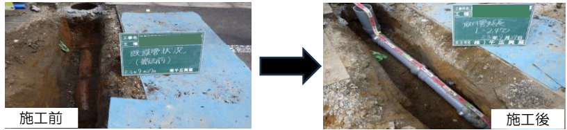
開削工：道路を掘削して古い管・ますを撤去し、新しい塩化ビニル管・ますへ取替
