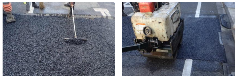
車道アスファルト舗装を新しく舗装する工事
