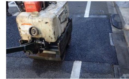
車道アスファルト舗装を新しく舗装する工事
