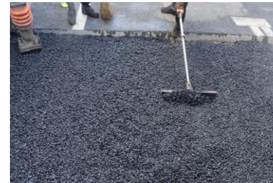
車道アスファルト舗装を新しく舗装する工事
