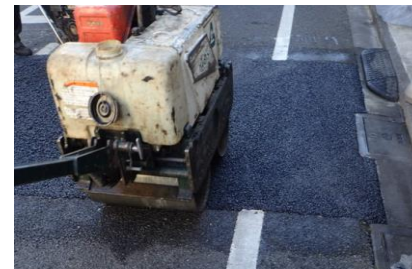
車道アスファルト舗装を新しく舗装する工事
