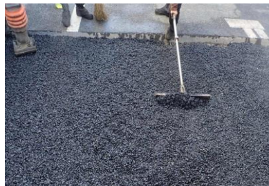
車道アスファルト舗装を新しく舗装する工事
