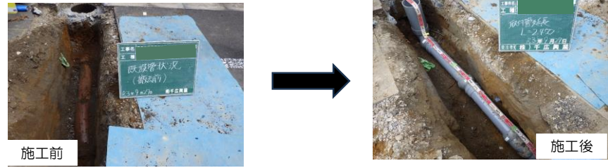
開削工：道路を掘削して古い管・ますを撤去し、新しい塩化ビニル管・ますへ取替
