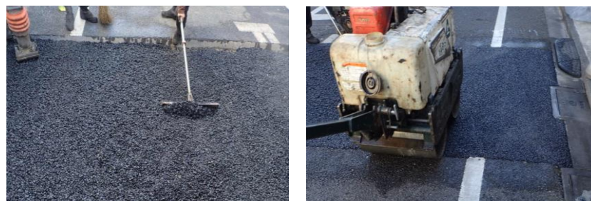
車道アスファルト舗装を新しく舗設する工事
