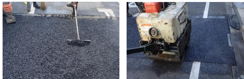
車道アスファルト舗装を新しく舗装する工事
