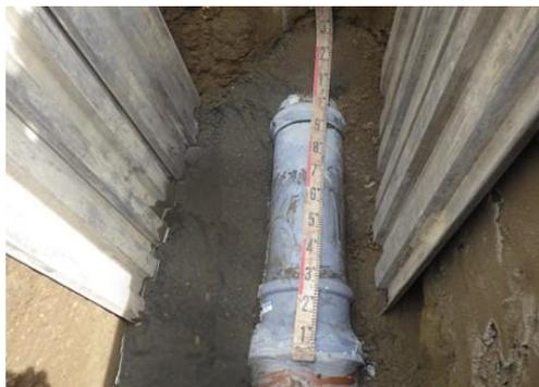
開削工事にて道路を掘削して古い管を撤去し、
