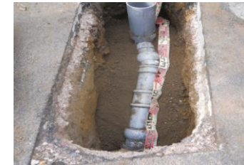
道路を掘削して古い管を撤去し、 新しい塩化ビニル管へ入れ替え
