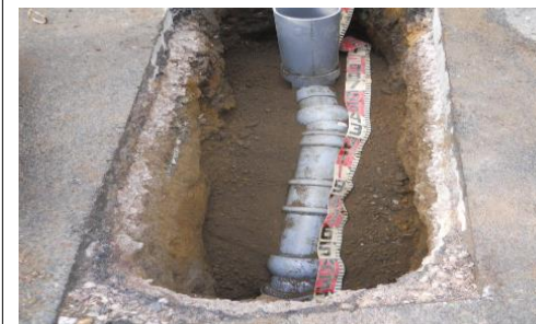
開削工にて道路を掘削して古い管を撤去し、 新しい塩化ビニル管へ入れ替え
