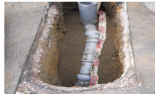
開削工事にて道路を掘削して古い管を撤去し、新しい塩化ビニル管へ入れ替え
