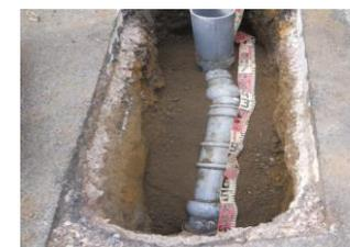
内面被覆工事にて補修した取付管
