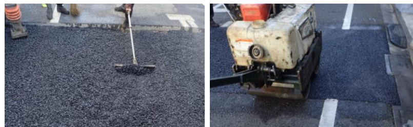
車道アスファルト舗装を新しく舗装する工事
