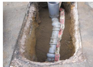
道路を掘削して古い管を撤去し、 新しい塩化ビニル管へ入れ替え
