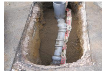
道路を掘削して古い管を撤去し、新しい塩化ビニル管へ入れ替え
