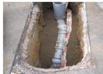
掘削して新しい埋設管へ入替えた「本管と取付管」
