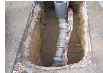
新しい強化ビニル管へ 入替えた「本管と取付管」
