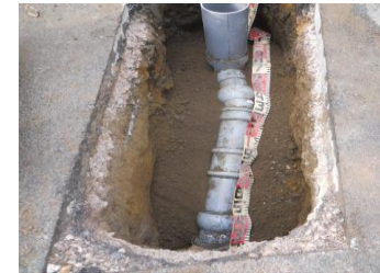
新しい大径化ビニル管へ 入替えた「本管と取付管」
