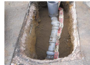
新しい「標準化」した管へ 入替えた「本管と取付管」
