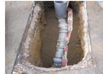
新しい「強化プラスチック管」へ 入れ替えた「本管と取付管」
