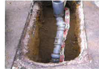
新しい「埋戻して 入替えだ！本管と取替管」
