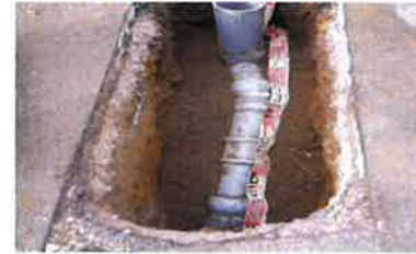
新しい環型シベ管へ 入替えた「本管と取付管」
